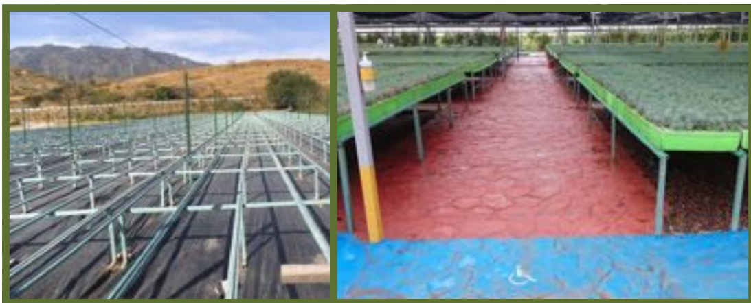
Figura 42. Pasillos y pisos limpios y libres de malezas.
